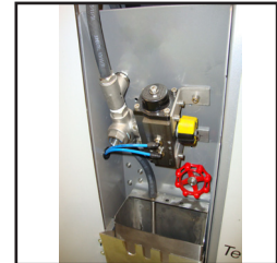
Additivbehälter mit einer Kapazität von ca. 5 kg
